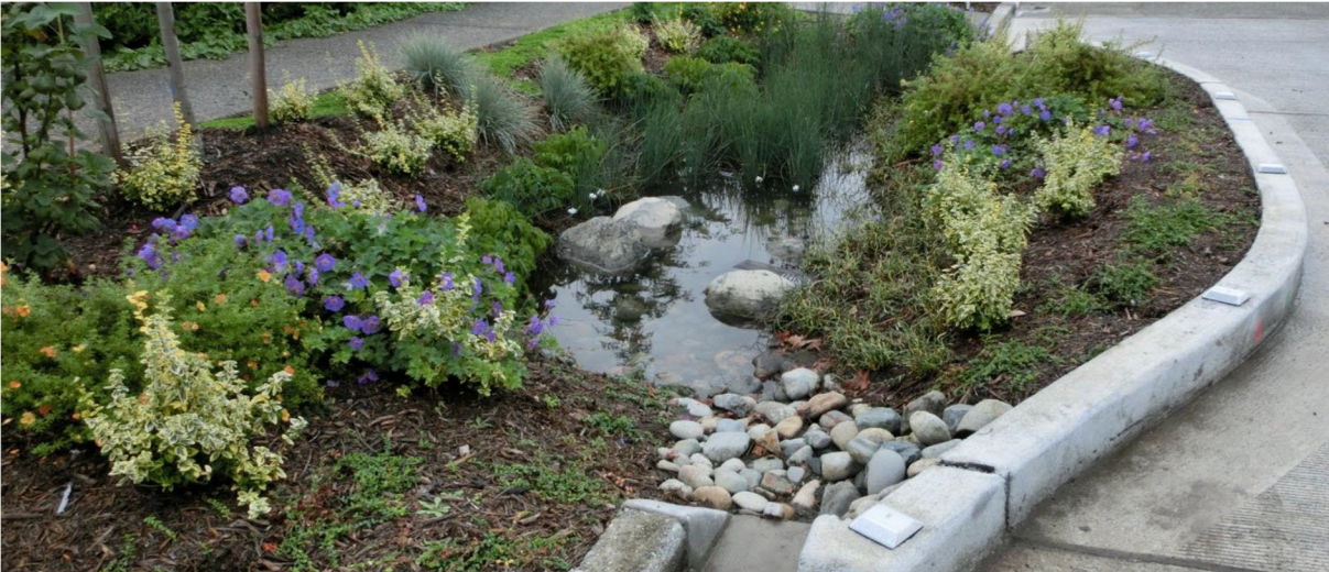
Figur 4 Eksempel på utforming av regnbed
