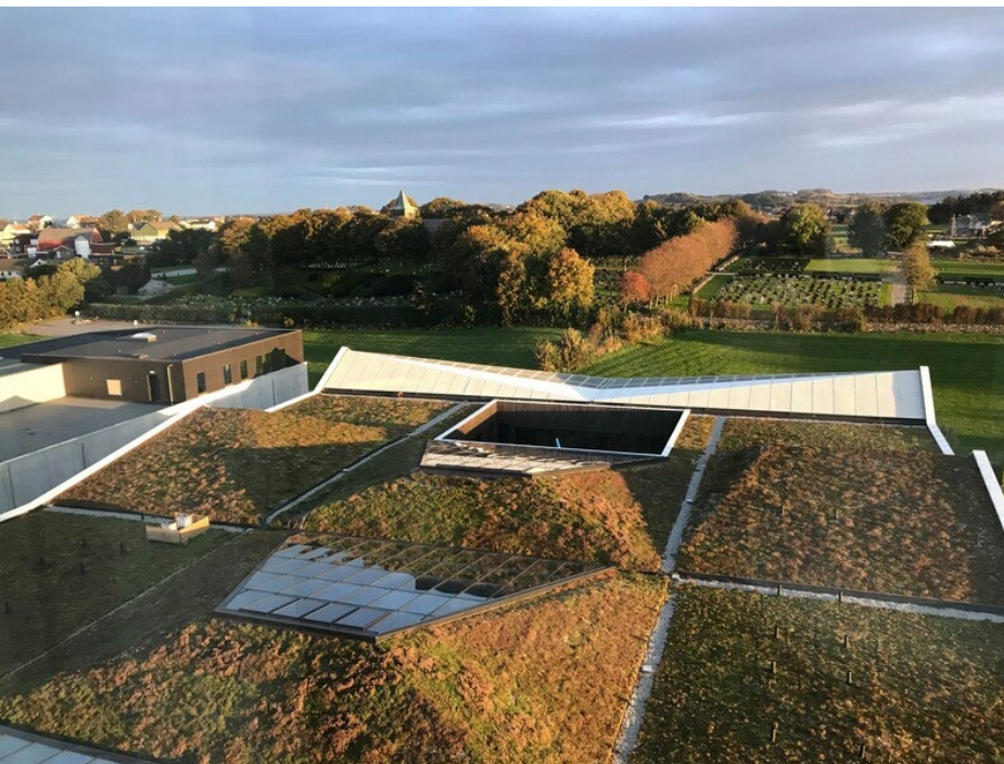
Figur 5 Grønne tak (vannforeningen.no)
