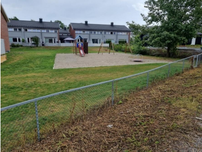
Figur 17: Lekeplass i Hasselsstien borettslag
