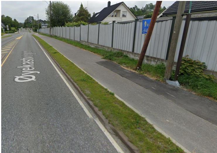
Figur 19: Støyskjerm og eksisterende boliger fra Øyekastveien mot Gjøavegen
