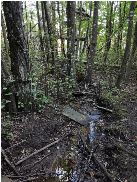
Flomløpet går i eroderte jordmasser
