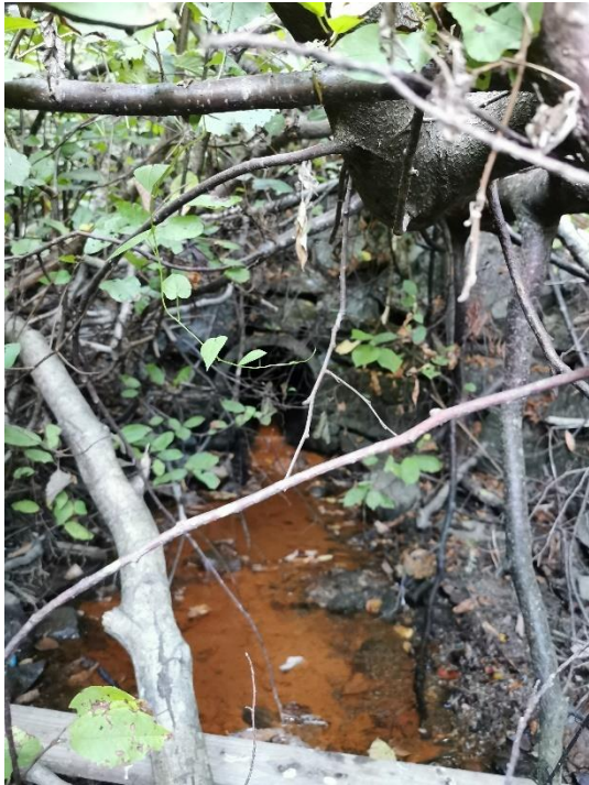
Utløp av eksisterende overvannsledning
