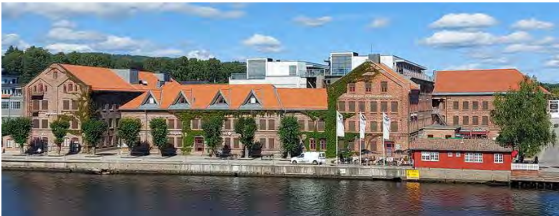
Bildet viser fasaden på Porsgrunns porselensfabrikk.
