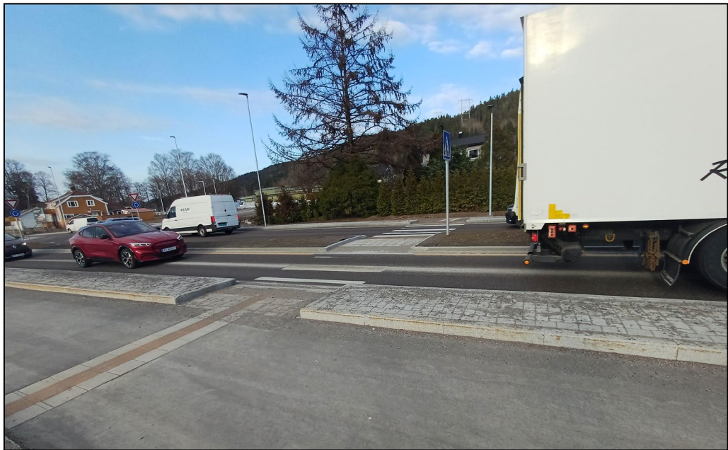
Figur 3 Gangfelt ved rundkjøring i krysset Vallermyrveien x Bjørndalvegen
