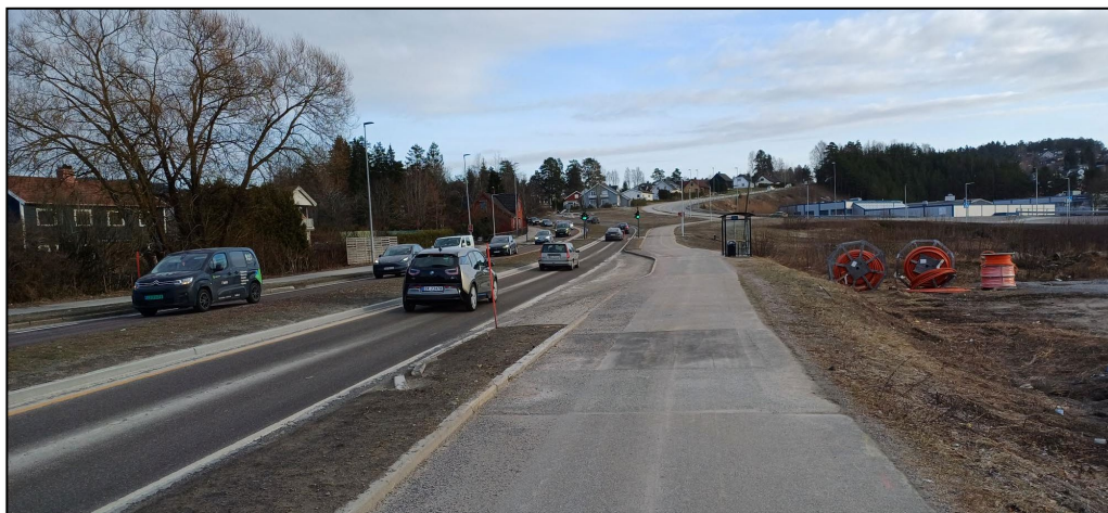
Figur 2 Ny gang- sykkelveg langs Vallermyrveien sett mot sørøst. Ny busslomme sees i bildet
