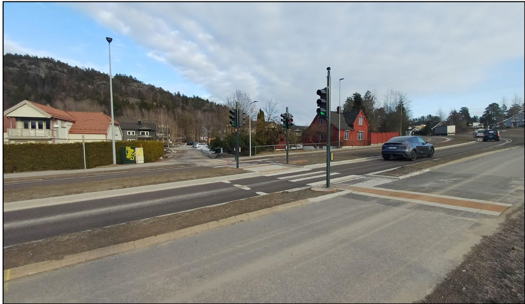
Figur 4 Lysregulert fotgjengerovergang i gangvei fra Bjørndalvegen øst for busstoppet
