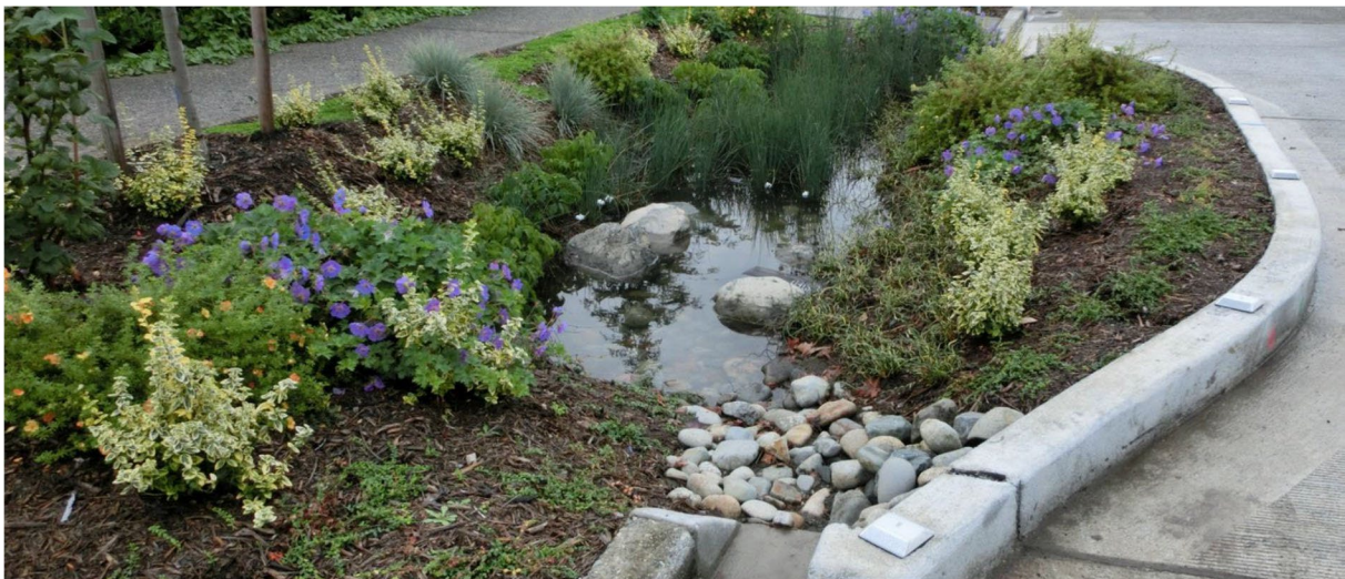
Figur 8 Eksempel på utforming av regnbed
