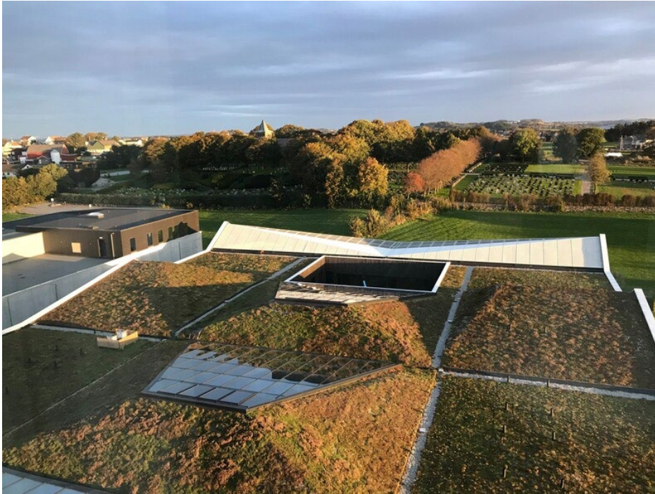
Figur 9 Grønne tak (vannforeningen.no)
