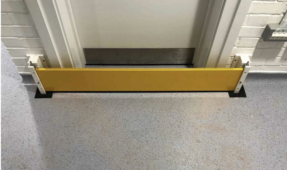
Figur 16 Eksempel på flomsikring av dør
