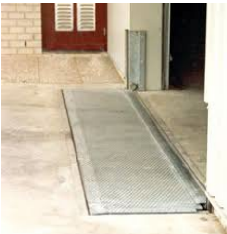
Figur 17 Flomsikring av port
