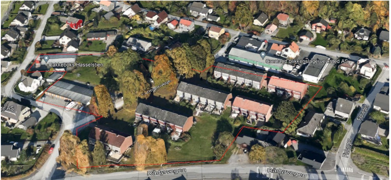
Figur 2 Planområdet i skråfoto med plangrense sett fra sørvest (Google maps)
