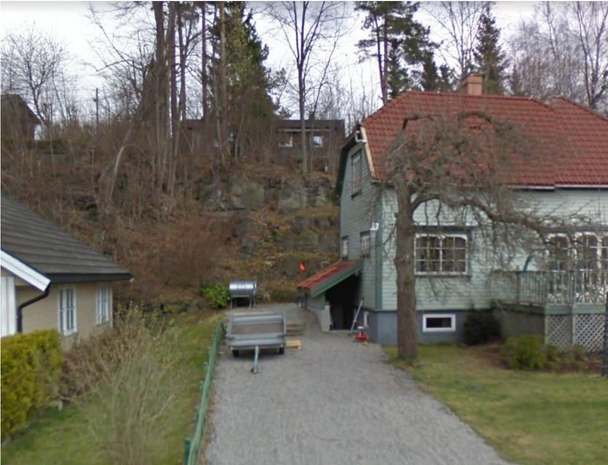
Figur 11 Skråning med fjell ved Rønningvegen 36
