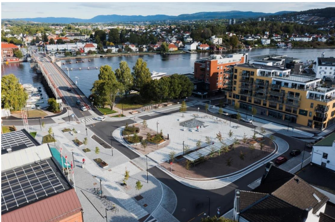
Figur 2-5: Oversiktsbilde som viser Franklintorget etter ombygging (bilde hentet fra: Porsgrunn.kommune.no).
