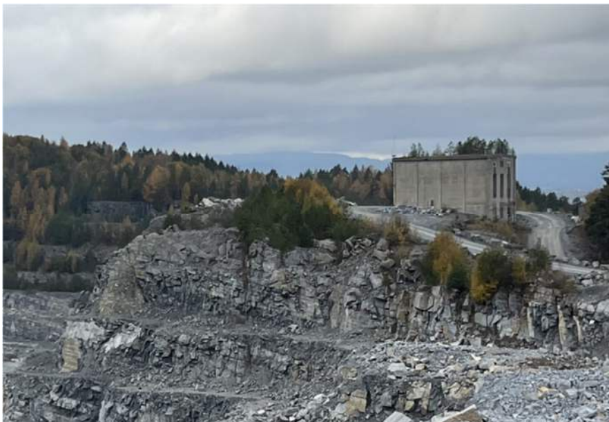
Figur 4-8. Bilde av bygg for knuseverk.
