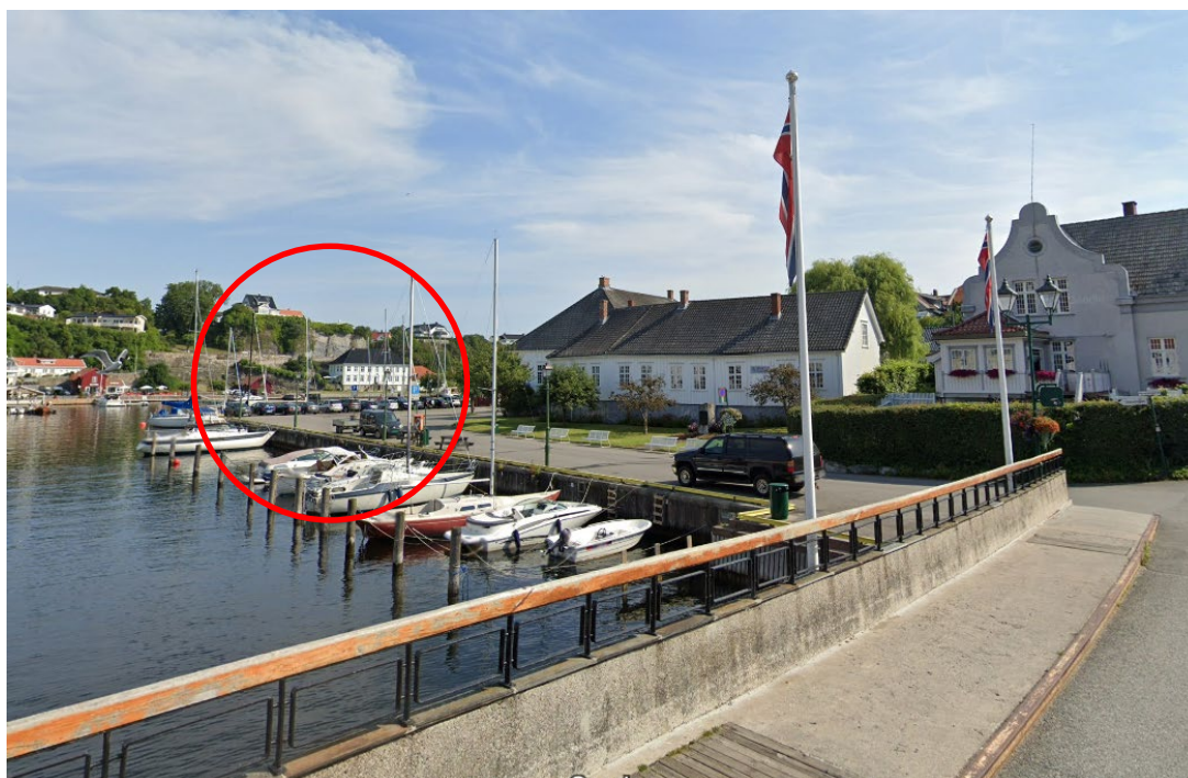
Figur 6: viser planområdet sett fra brua til Øya i Brevik.
